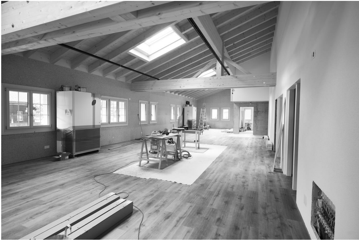
(Fitnessraum im Obergeschoss Richtung Norden)
